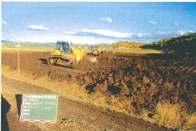
協栄地区第31工区 整地工事
