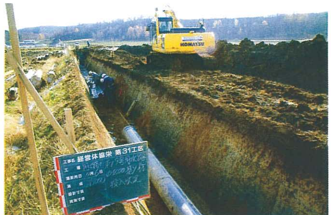
協栄地区第31工区 用水路工事
