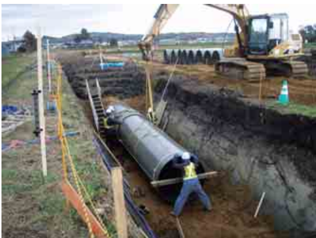
(道営かんがい排水事業秩父別3幹地区 第3幹線：FRPM管φ1,350m埋設状況)
