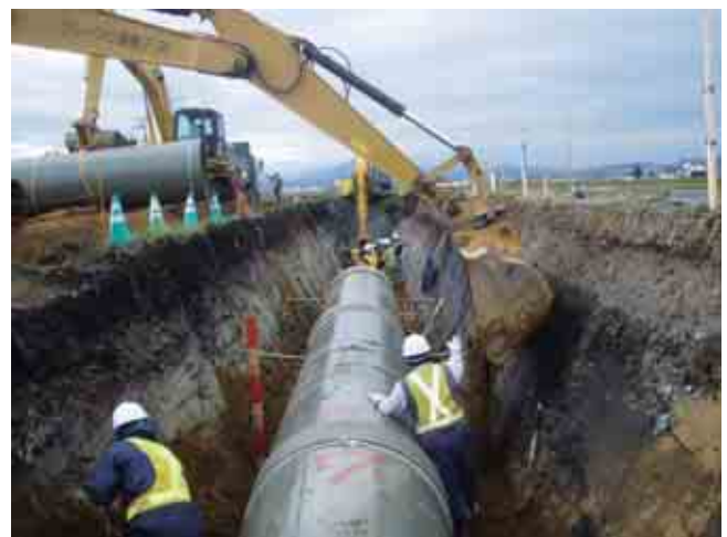
(道営かんがい排水事業秩父別3幹地区 第3幹線：FRPM管φ1,350m埋設状況)
