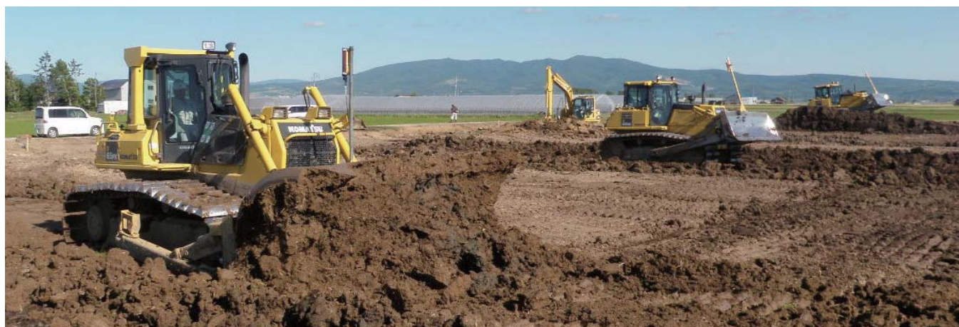
夏期施工（桜川第2地区）による整地工事の様子 『(有) HJY さくら』ほ場
