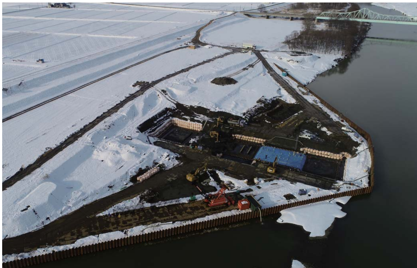
雨竜川を半川締切により施工する八丁目頭首工の様子
