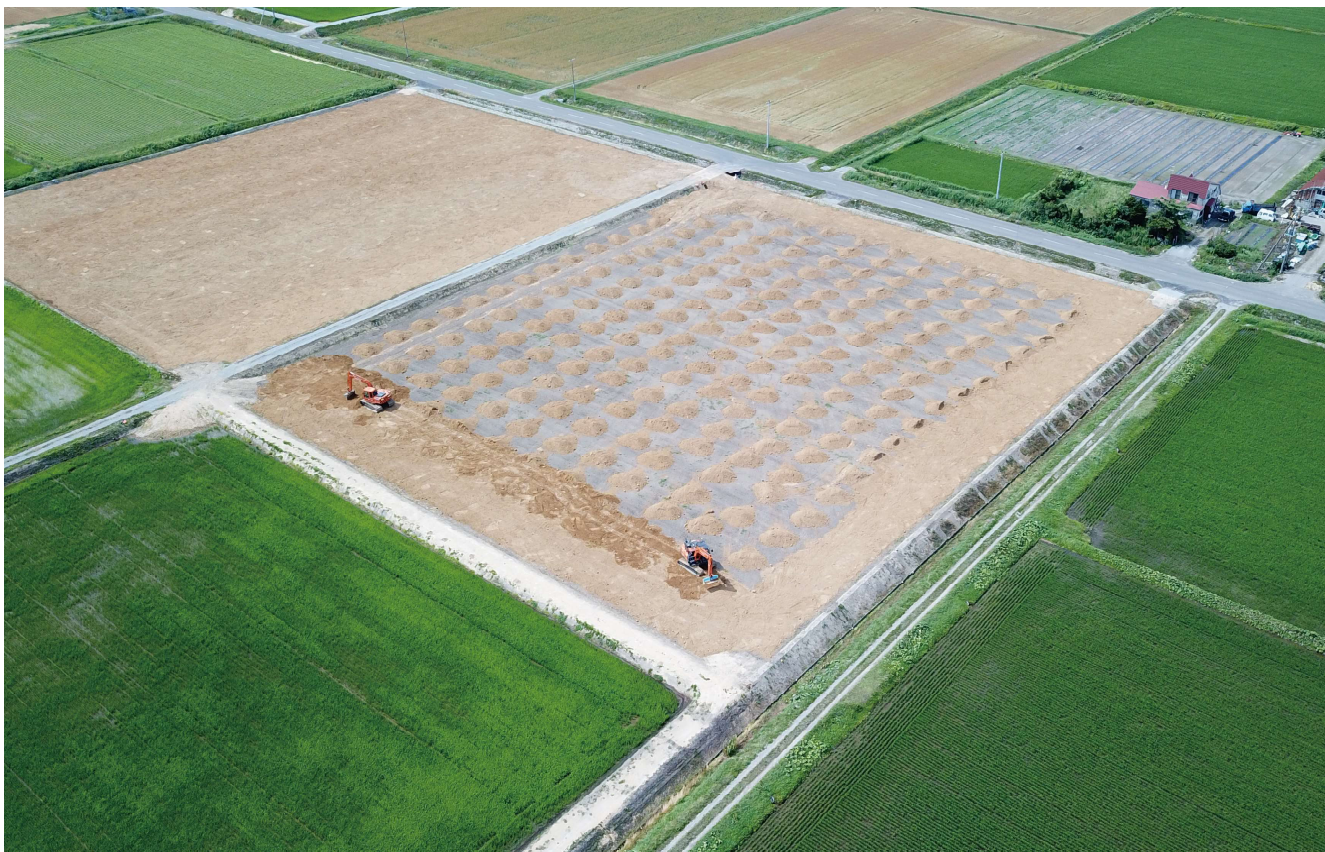
道営農地整備事業千秋第2地区客土工事の様子
