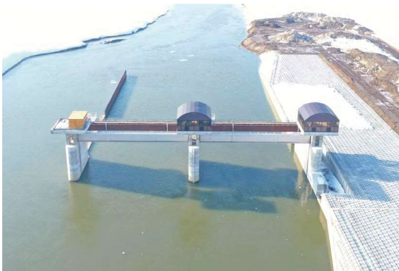
建設中の八丁目頭首工の様子
